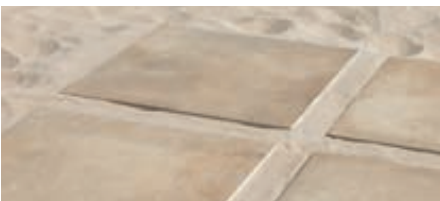
EN SECO ARENA DRY SAND Colocación directa sobre arena Direct installation over sand.
