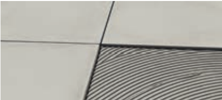
TRADICIONAL TRADITIONAL Colocación con pegamento doble encolado Installation with double paste coating
